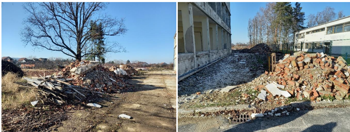
Slika 4. Otpad nastao tijekom dosad provedenih pripremnih radova (desno: otpad koji će biti odvezen i zbrinut do kraja srpnja 2022)
